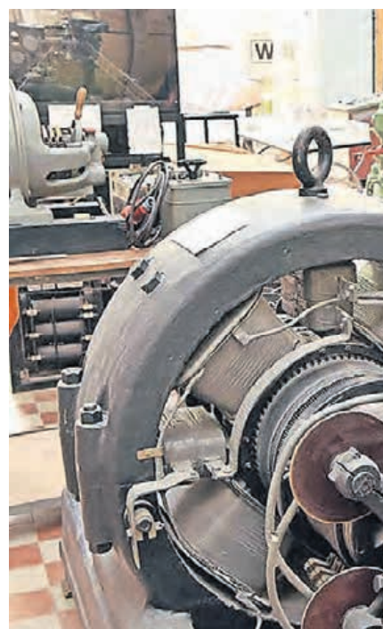
Dieser Anker-Umformer wandelte Drehstrom in
