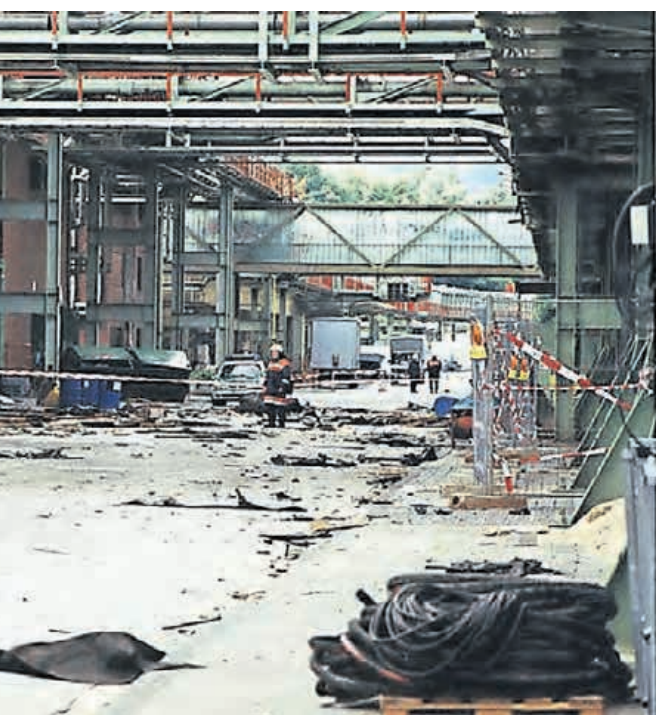
ung: Im Juni 1999 explodierte im Bayer-Werk eine Fabrikhalle. Noch in der eben. Rund 100 Menschen wurden verletzt - angesichts der schweren Explo- ng. Ein Arbeiter hatte Ätzkali mit Pottasche verwechselt, was zu einer hef- Archiv-Foto: Wolfgang Westerholz
