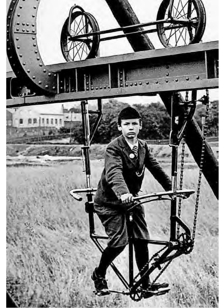
So sahen die ersten Versuche von Schwebahn-Erfinder Eugen Langen aus: Per Schwebe-Fahrrad demonstrierte er 1895 auf einer Teststrecke in Köln-Deutz seine Idee eines schwebenden Gefährts. Die Industriellen aus dem engen Wuppertal waren begeistert.
