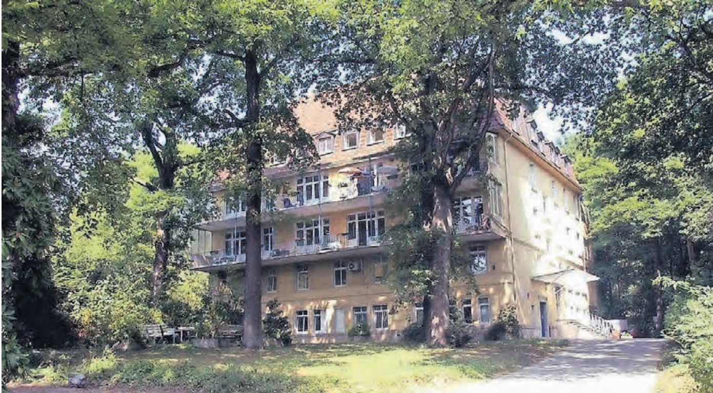
Eines der ältesten Häuser auf dem weitläufigen Gelände der Diakonie Aprath ist dieses Pflegeheim.
