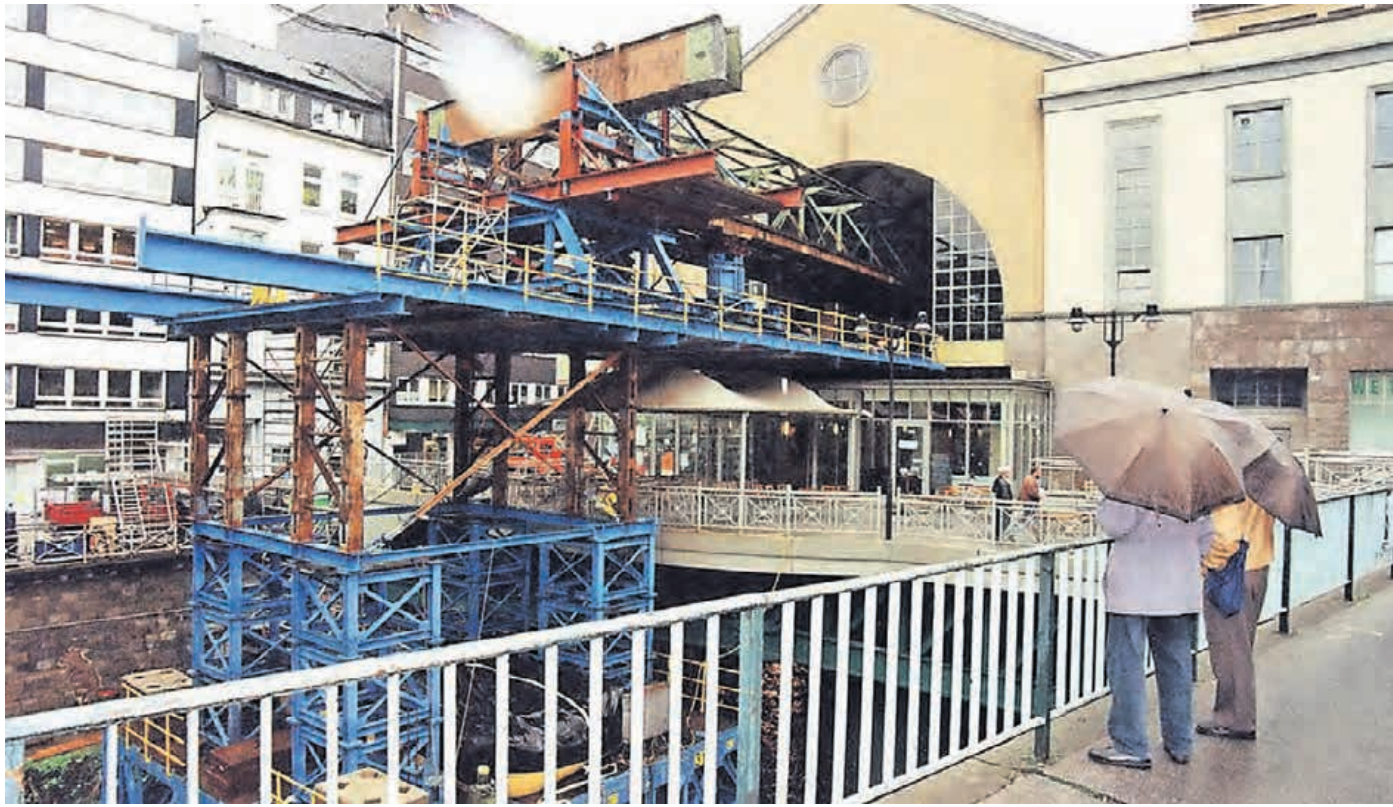
Die Haltestelle Döppersberg blieb, aber die Gleise wurden komplett ausgetauscht.
