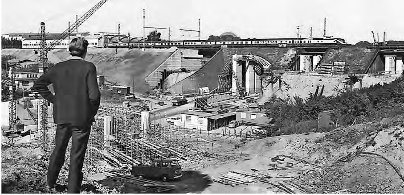
Sonnborn beim Bau der Autobahn – eine Aufnahme aus dem Buch „Verkehrsknoten Wuppertal“.
