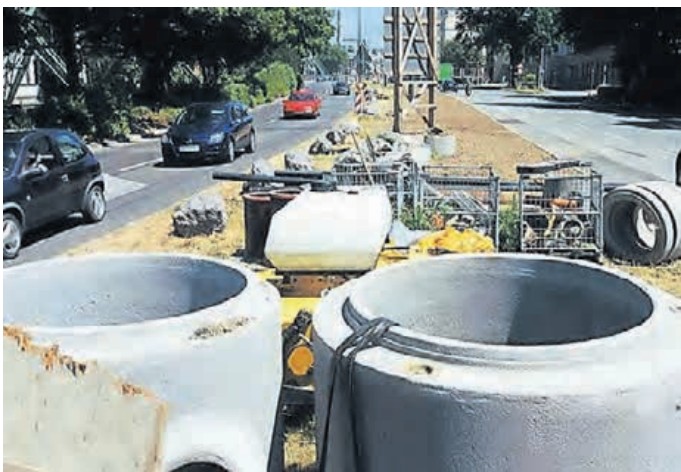
Sorgte jahrelang für Baustellen: der Wuppersammler. Archiv-Foto: Kurt Keil
