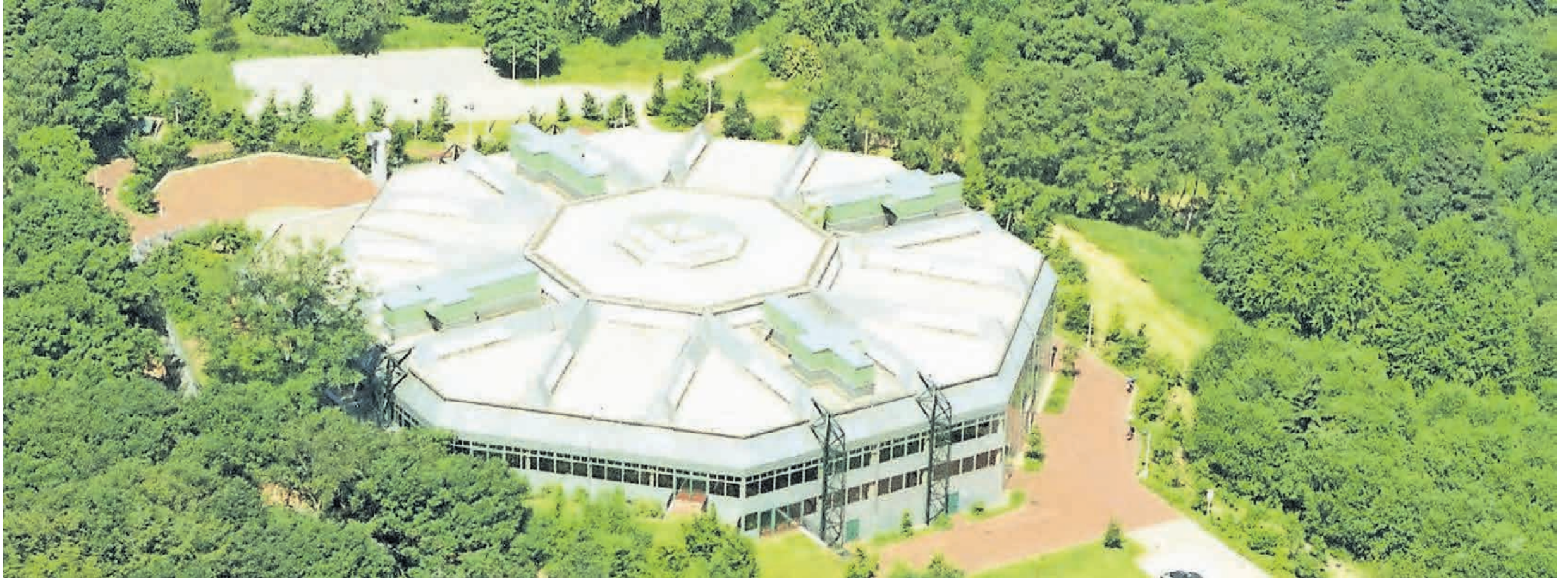
Die Uni-Halle gehört der Stadt und der Bergischen Universität. Daher mussten die Eigentümer im Laufe der Jahre viele Kompromisse eingehen. Probleme bereitet seit Jahren auch die Fehlkonstruktion des Daches. Dieses Problem ist ungelöst.
