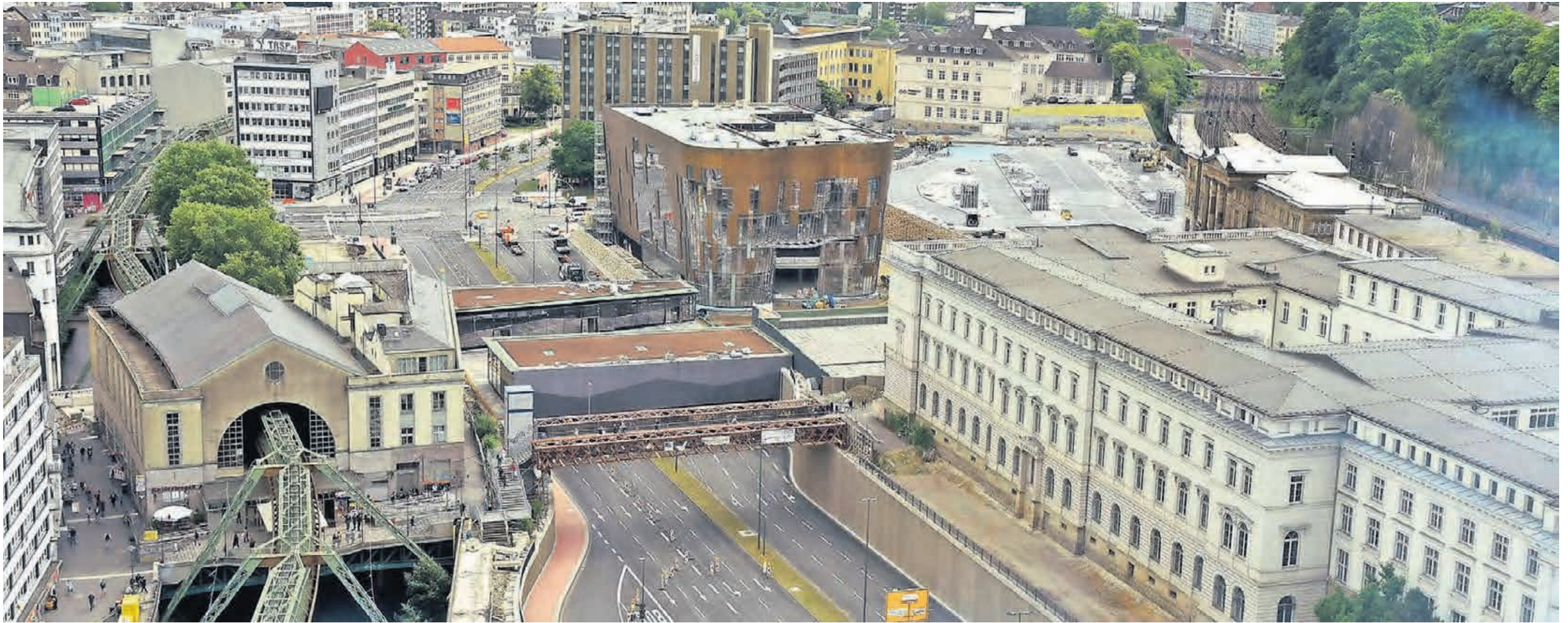
Wenn bald alles fertig ist, erwartet die Wuppertaler und ihre Gäste ein eleganter Zugang vom Hauptbahnhof in die Innenstadt.
