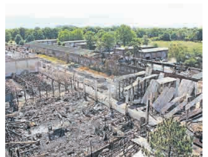
Die Zerstörung durch die Flammen ist deutlich zu sehen. Foto: Monderkamp
