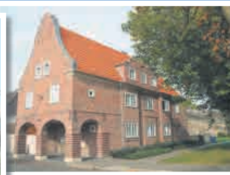
Kernsanierung Kohlplatzweg / Linn
