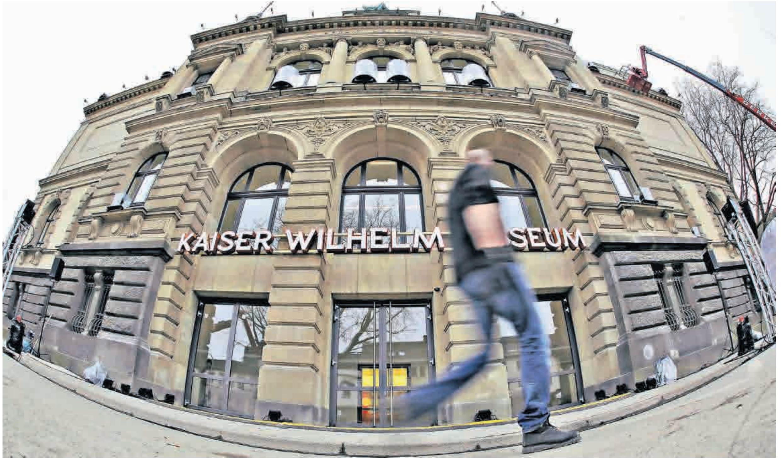
Das Kaiser-Wilhelm-Museum ist gerade nach jahrelangem Umbau fertiggestellt worden. Die Kunst zieht bis Juli ins Haus ein.
