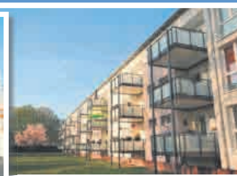
Kernsanierung Breslauer Str. / Gartenstadt
