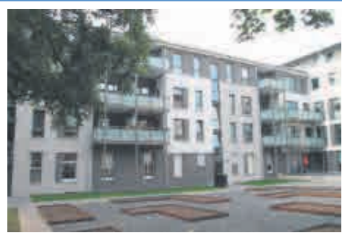
Kernsanierung Friedrichstraße / Centrum
